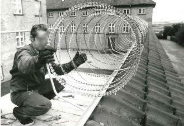
NATO-tråd sættes på den østlige ringmur, 1984.
